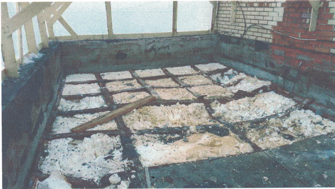
Фото 17. Частичный ремонт. Состояние кровельного пирога во время ремонта.
